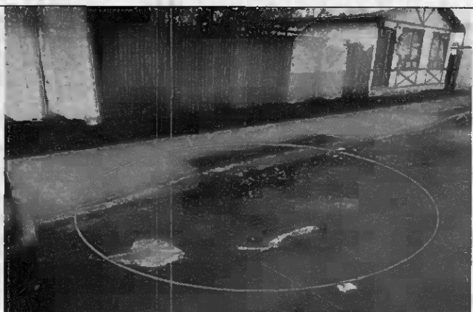
Fotografía N° 4: restos de materiales, basura y desechos en la vía pública
