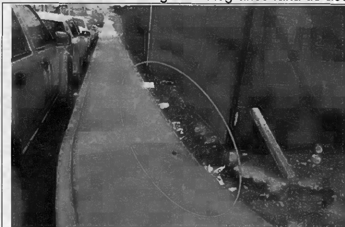
Fotografía N° 1: restos de materiales, basura y desechos en la vía pública
